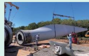
例：風力発電のブレードの解体
