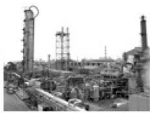
アンモニア製造設備
