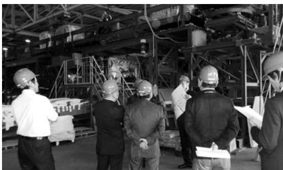
自動投入設備
