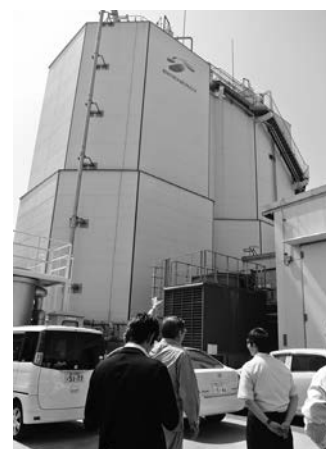
メタン発酵槽
