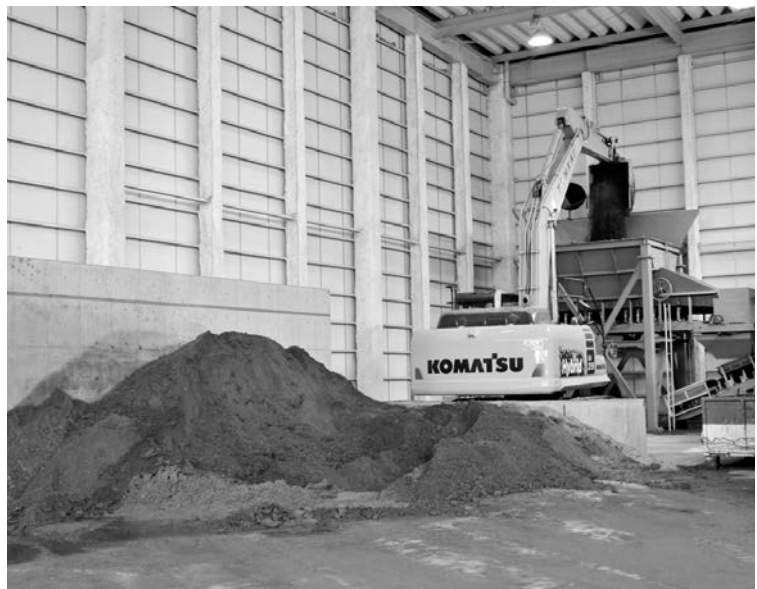
土砂の投入口
