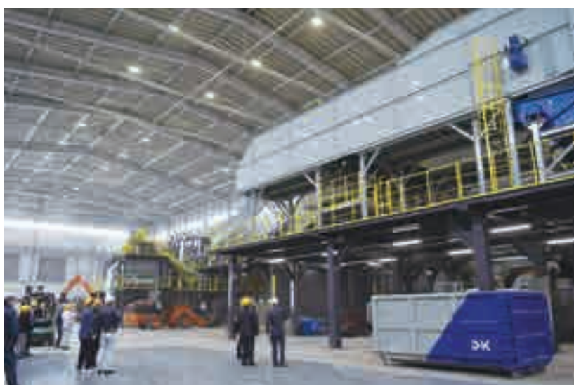
試験運転中の三田事業所を見学
