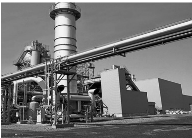
ガス化熔融炉 （共英製鋼ホームページより）
