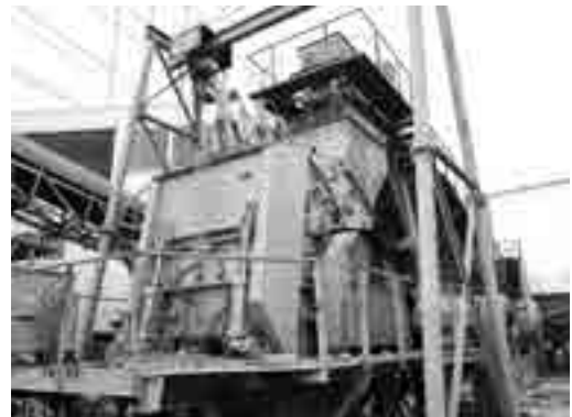
コンクリート廃材破碎選別プラント
