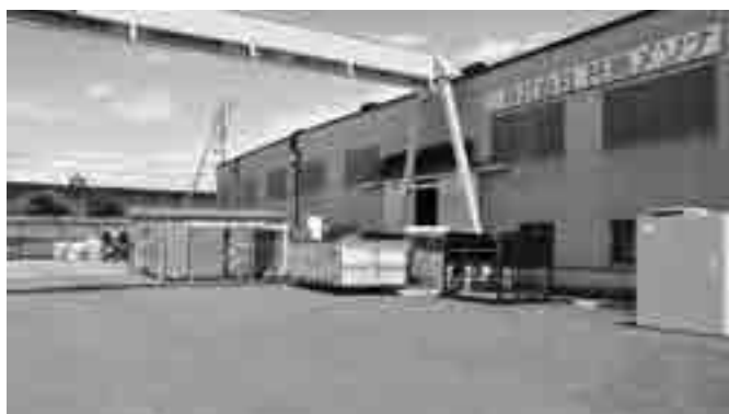
新たに整備したスクラップ解体場
