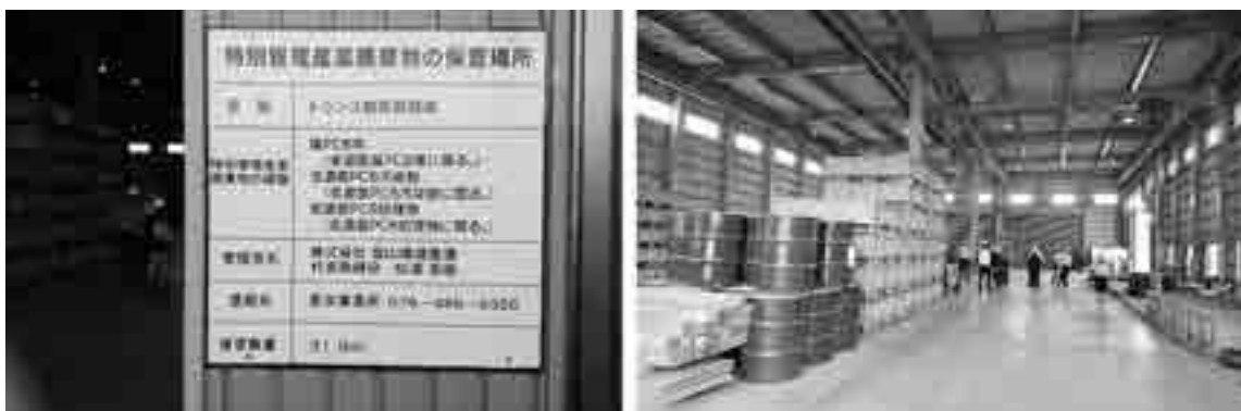
写真：低濃度PCB保管施設
