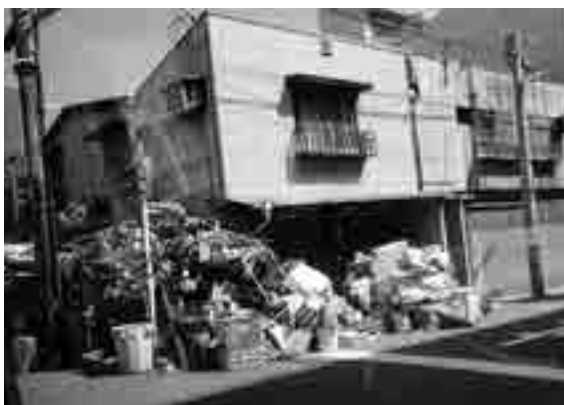
廃業した工場か？周辺住民や通行人にとって大変危険である
