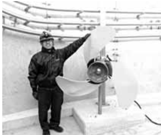
加温配管と攪拌機（発酵槽内部）
