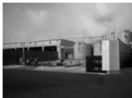
南港東プラント
