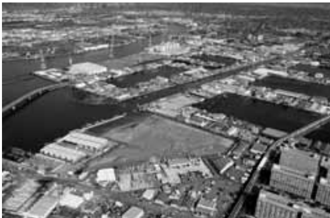
南港東プラント 埋立中の様子（2013年10月現在）
