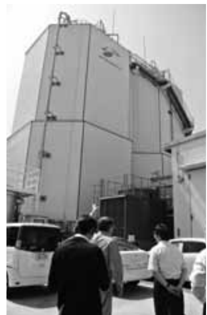
メタン発酵槽
