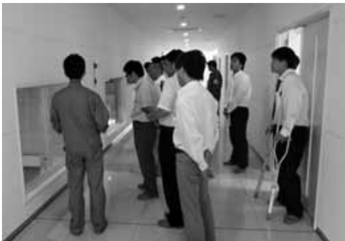
建屋内から設備見学中
