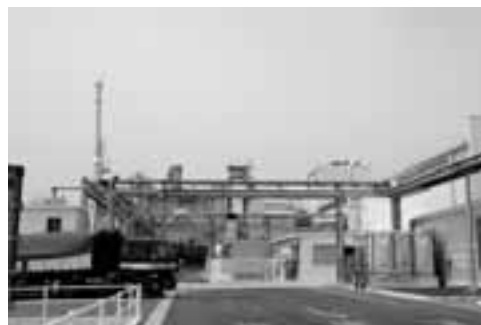
排水、排ガス設備
