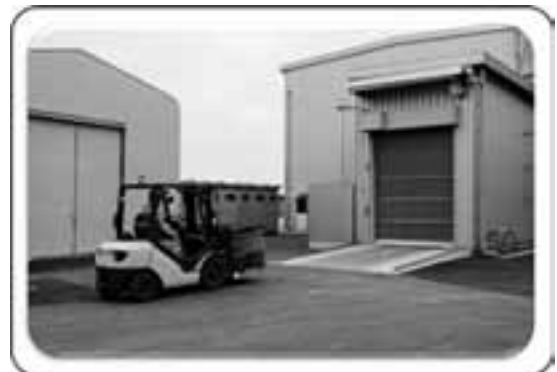
図2.2.6-2 飛散防止措置が講じられた施設内移動の例
