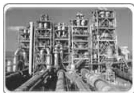
図1.5.1-4 セメント製造施設の例
