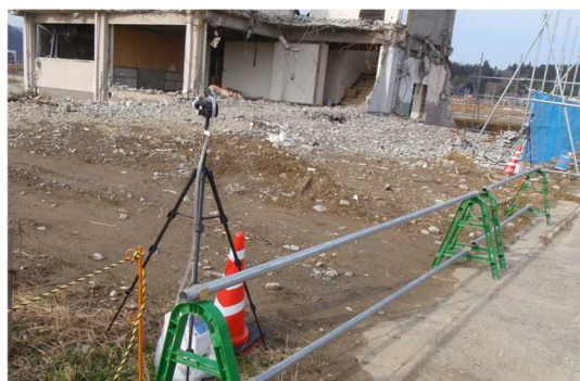
損壊建築物近傍での測定例
