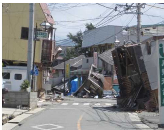
損壊建物（地震）
