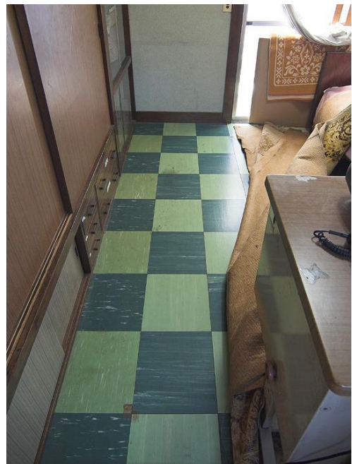
④石綿含有ビニル床タイル
