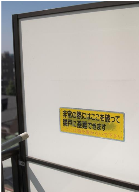
⑦石綿含有フレキシブル板
