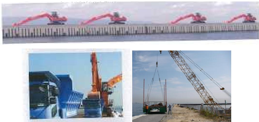
写真 7-7 廃棄物運搬船から荷降ろしをする大型バックホウ（上）と場内運搬用の 11 トンダンプロトラック（総重量 20 トン）（左下）、移動式 25 トンラフタークレーンによる作業（右下）
