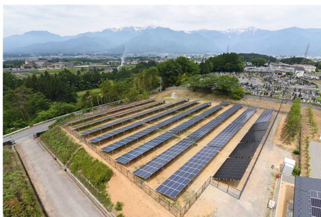
図表 56 リユース品を使用した発電所
